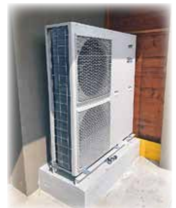
Wärmepumpe Heim Aussen- gerät LIA 12IM T-Cap
