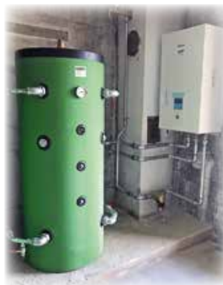
Wärmepumpe Heim Innen- gerät LIA 12IM T-Cap
