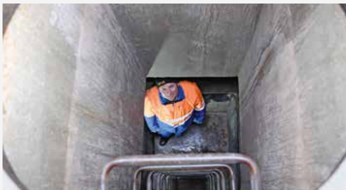
Blick in den Sammelschacht unterhalb der Käseerei Wyssbach
