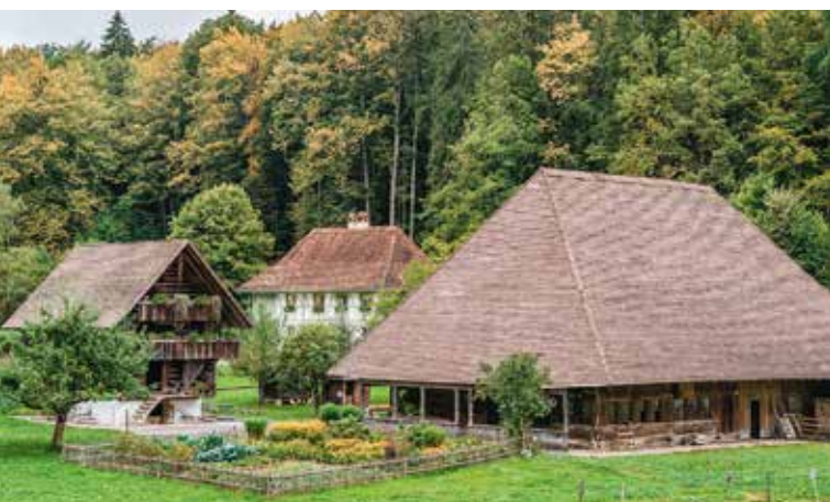
Der heutige Zustand des Hauses auf dem Ballenberg
